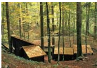
Obnovljena bolnišnica Jelendol, postavljena v kraški vrtači v bližini Baze 20 pod Daleč hribom.
