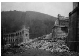
Porušen viadukt v Borovnici 1941
