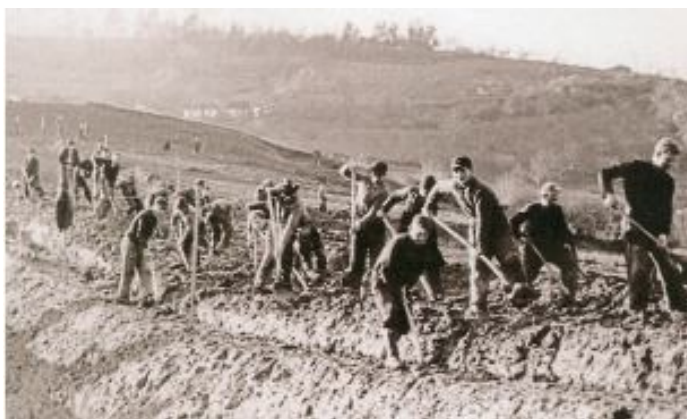
Slika 1: Gradnja obrambe »Sudostwall«
