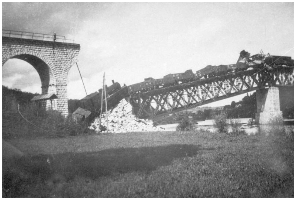
Slika 10: Miniranje desnega obrežnega steber mostu čez Krko
