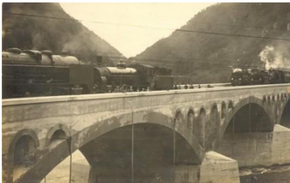
Slika2: Novo zgrajen most v Zidanem Mostu
