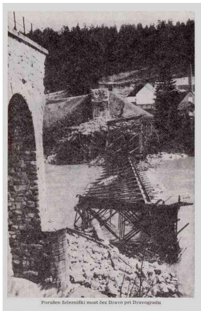
Slika 12: Porušen železniški most čez Dravo pri Dravogradu
