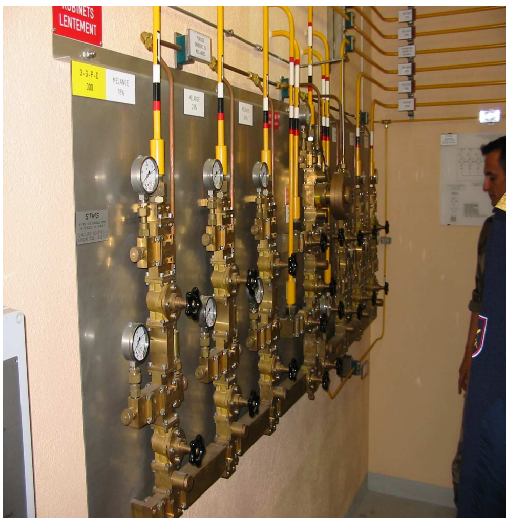
Slika 7: Razdelilna plošča za pripravo plinskih mešanic
