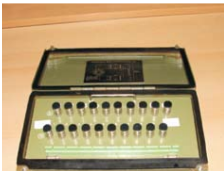
Slika 15: Priključna varovalna omarica PKON-10A
