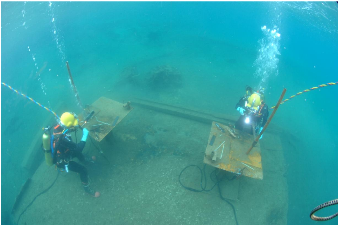
Slika 24: Potapljača SV, opremljena z opremo delovnih potapljačev med urjenjem podvodnega varjenja v Toulonu – Francija.
