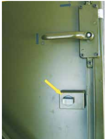
Slika 9: Zaklepanje in odklepanje ključavnice iz notranjosti zabojnika.
