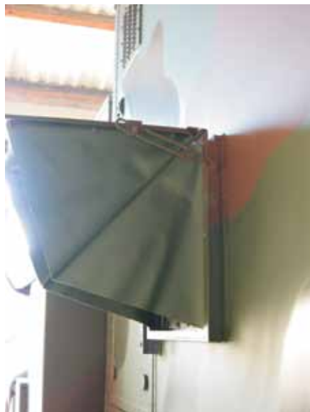
Slika 14: Fiksiranje aluminjaste lopute.
