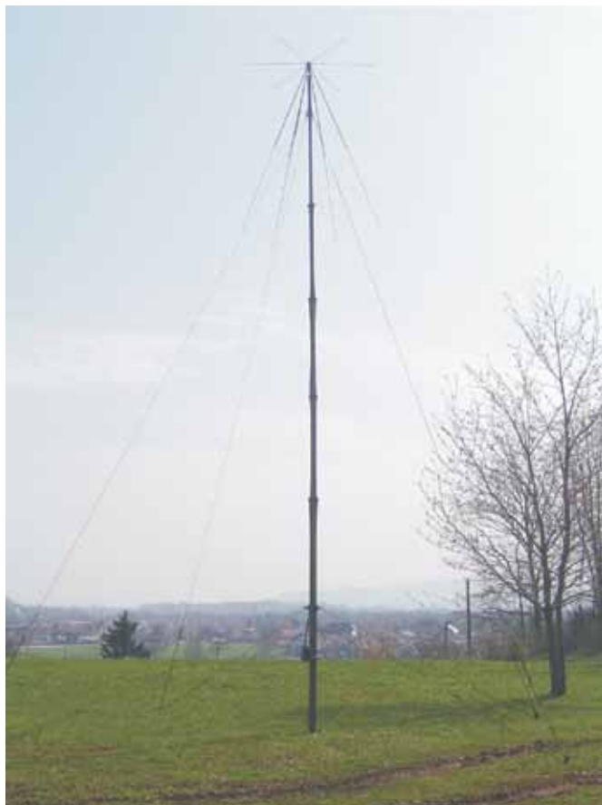
Slika 14: Antena AD-17 na stolpu tipa A.
