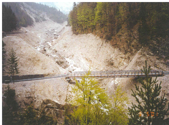
Slika 2: Izdelava mostu C 200 – Predel (januar 2001)
