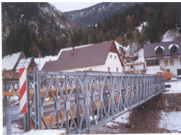
Slika 1: Izdelava mostu C 200 – Log pod Mangartom (oktober 2001)
