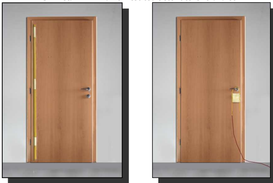
Sliki št. 41 in 42: Namestitev detonatorske vrvice
