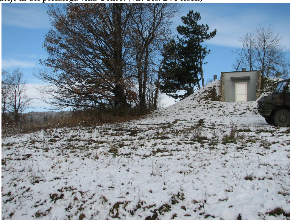
Slika št. 10: pogled z mikrolokacije v smeri sever – severozahod. Na sliki dobro vidno vodno zajetje, primeren vir oskrbe. (vir: des. D. Peršuh)
