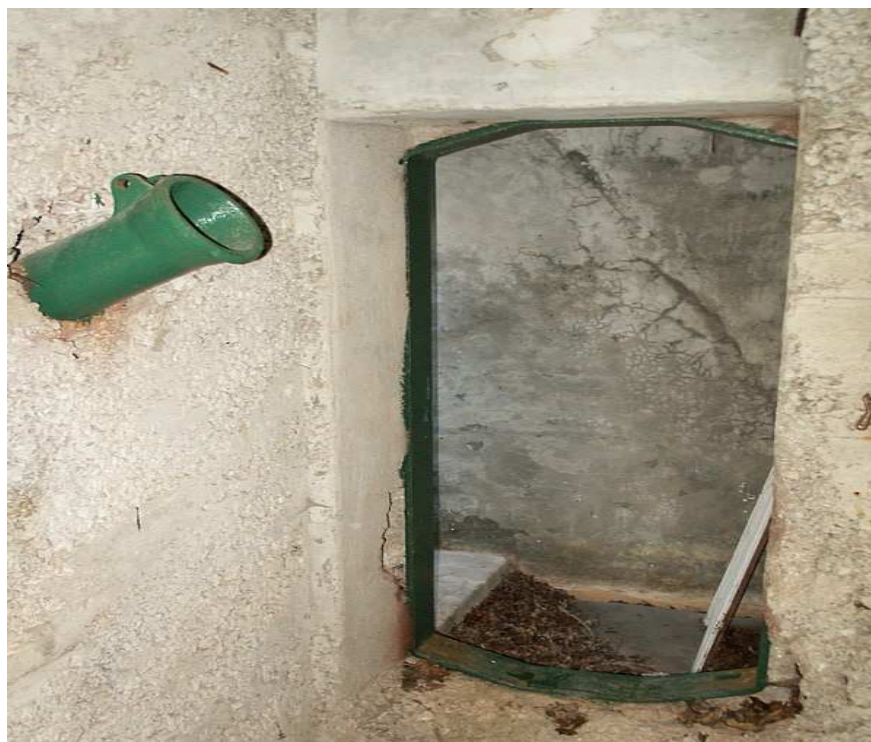
Slika 16: Odprtina za izpust ročnih bomb v notranjosti utrdbenega objekta na Kamenjaku
