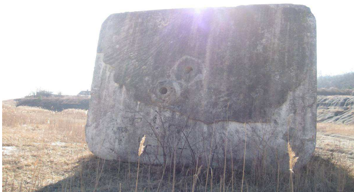
Slika 18: Prevrnjen bunker na obrobju Maribora- na stropu sta vidni dve odprtini za zračenje in izstrelke
