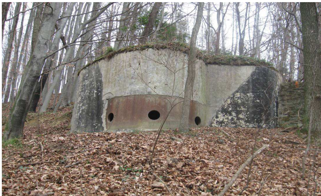
Slika 14: Hidroizolacija na objektu Rupnikove linije na obrobju Šentilja
