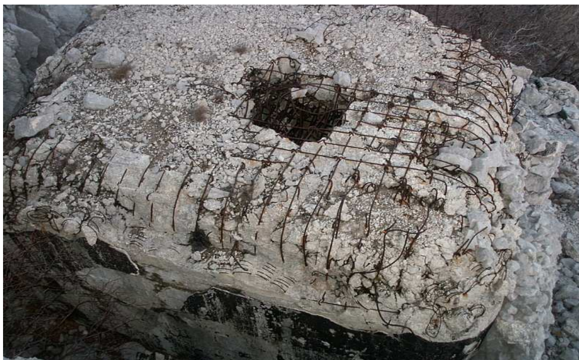
Slika 13: Vezava betona in železne armature
