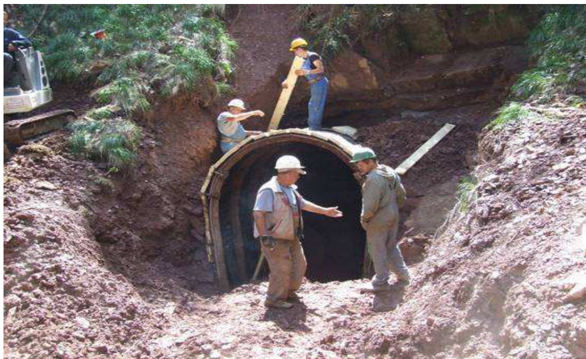
Slika 12: Dela na urejanju vhoda v slemensko utrdbo Goli vrh
