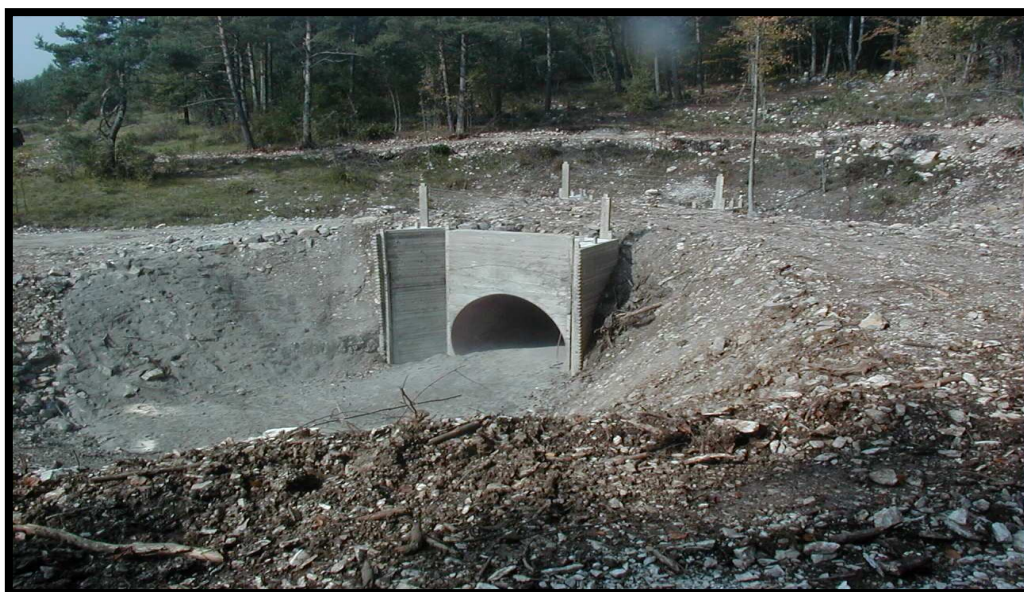
Slika 5: Tunel za uničevanje ubojnih sredstev z detonacijo
