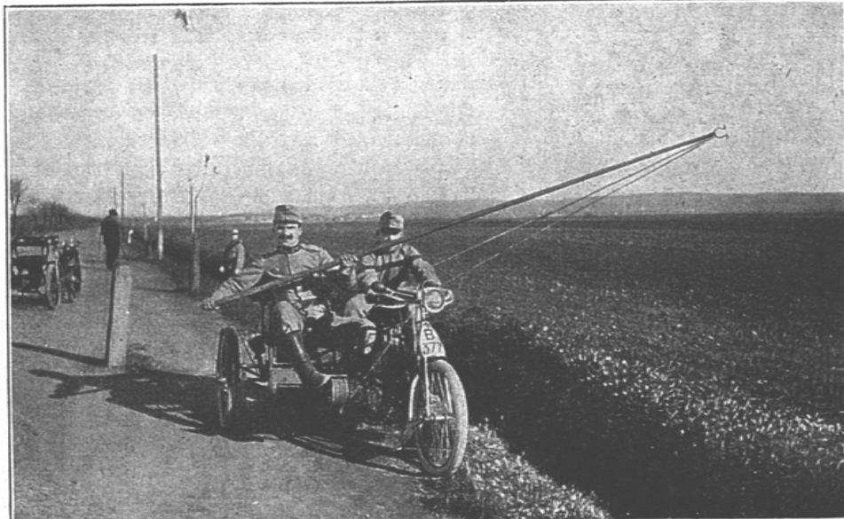
Slika 35, Vir: arhiv Mitja Močnik, 2007 Polaganje žice v obcestni kanal s pomočjo cevastih vilic
