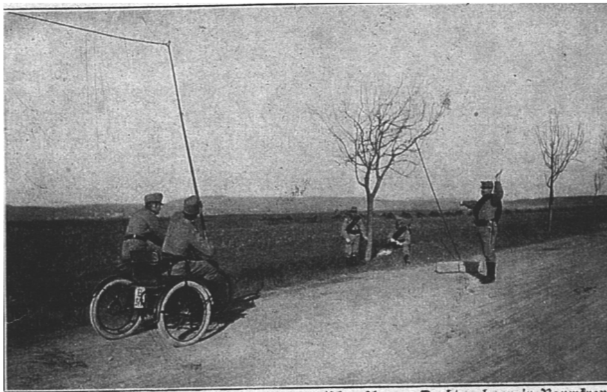
Slika 37, Vir: arhiv Mitja Močnik, 2007 Telegrafsko motorno kolo v Avstro-ogrski vojski: polaganje kabla po drevesnih krošnjah in vklop vmesne postaje.
