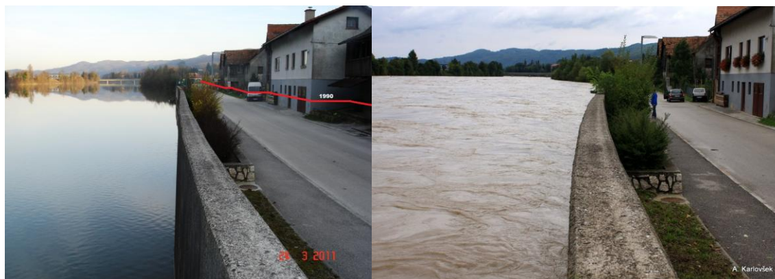
Slika 7: Protipoplavni zid v Radečah – Starograjska ulica (primerjalna slika; levo: prikaz poplav leta 1990, desno: jesenske poplave 2010)
