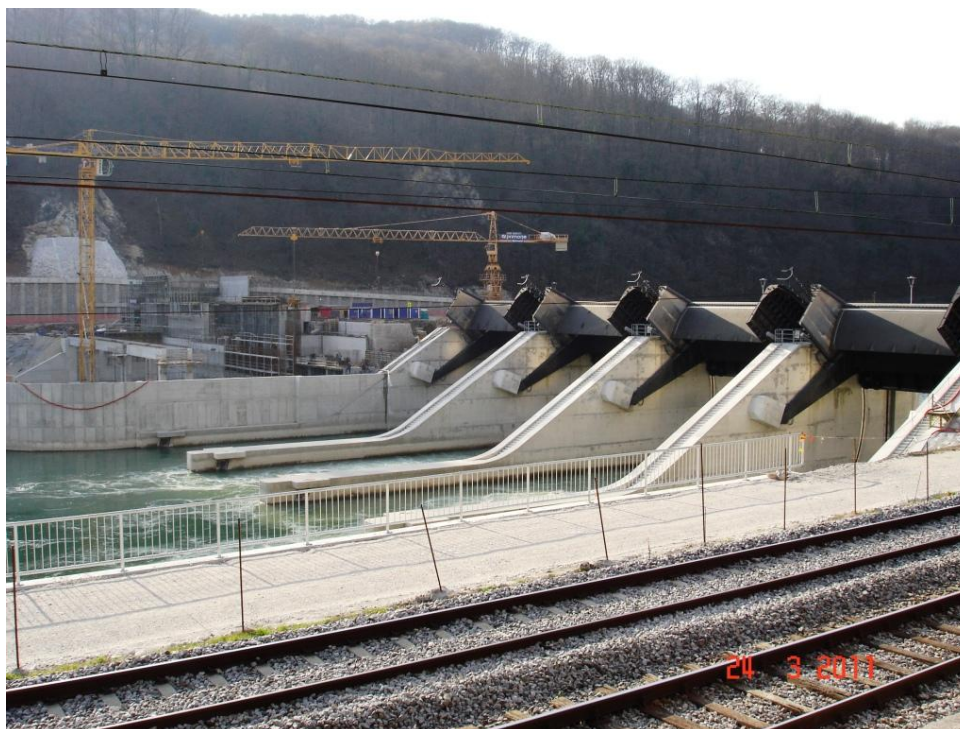
Slika 12: HE Krško v izgradnji
