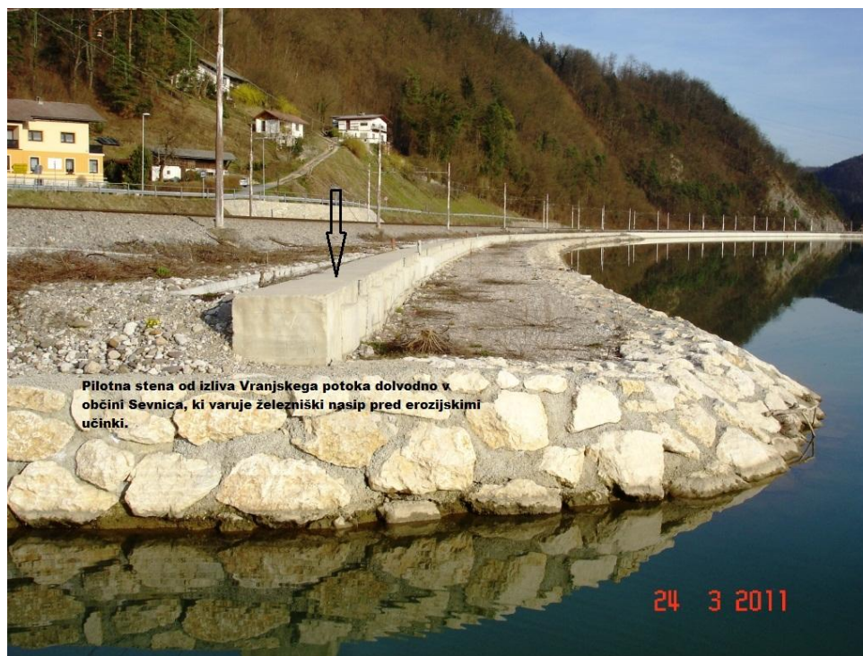
Slika 4: Pilotna stena (občina Sevnica)
