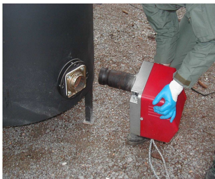
Slika 20: Namestitev gorilca
