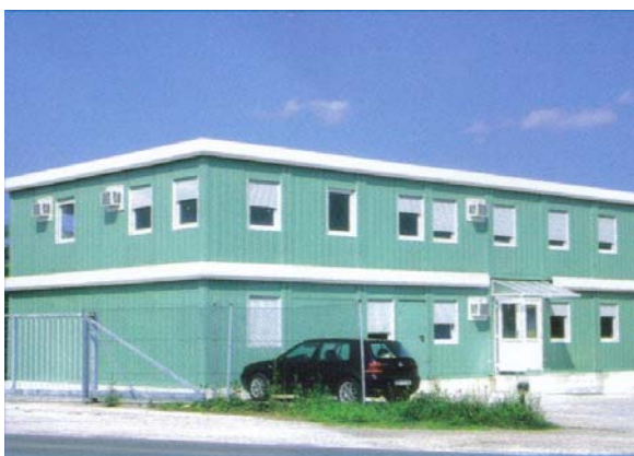
Slika 1: Montažno poslovni objekt
